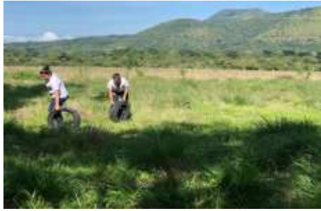
Fuente: Carlos Hernández Ilustración 35. Trabajo de la instalación del sistema de riego, Amatillo, Ipala, Chiquimula, 08 de julio de 2019.
