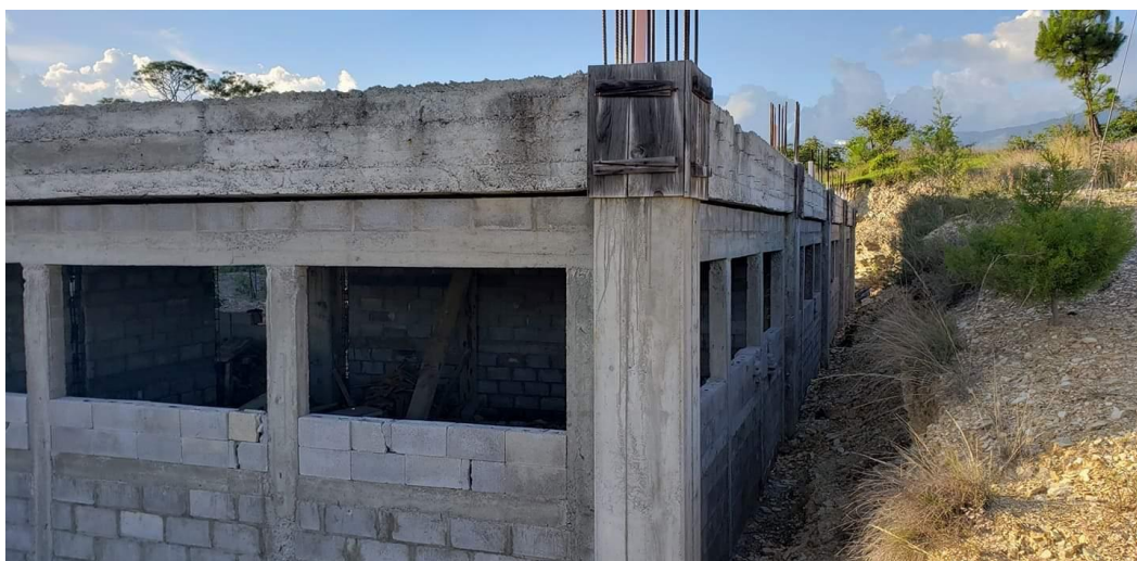
Fotografía donde se observa desde adentro las paredes terminadas. (Fotografía No. 4 de Alicia Cardona). (Huehuetenango 2019). Fotografías. -Voluntariado EPS-.
