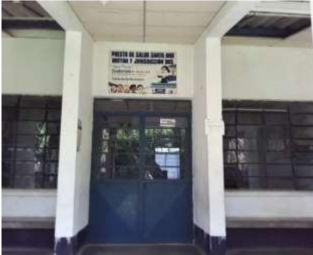
Edificio del puesto de Salud, Santa Ana Mixtán. Fuente propia: Abner Oswaldo Quiñonez y Quiñonez
