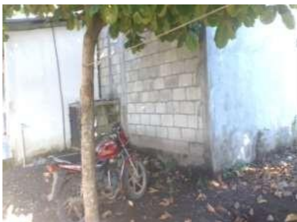
Lugar de la construcción. Fuente: Darly Catalán
