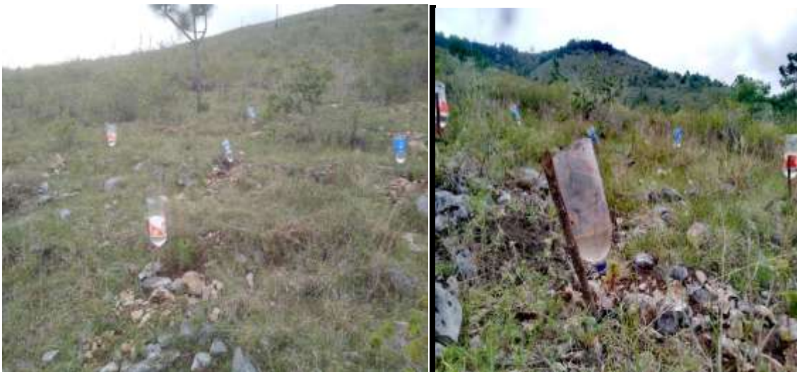
Foto 18. Sistema de riego finalizado
