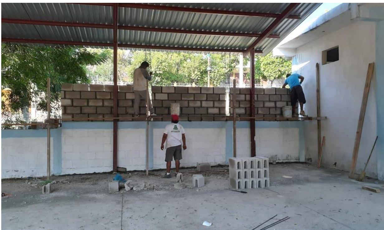
Fotografía 6 Construcción de la pared externa, esta pared da hacia la calle, misma que debe ser sellada para evitar el ruido que hace el tráfico vehicular que transita por el lugar. Fotografía tomada por Epesistas 2019
