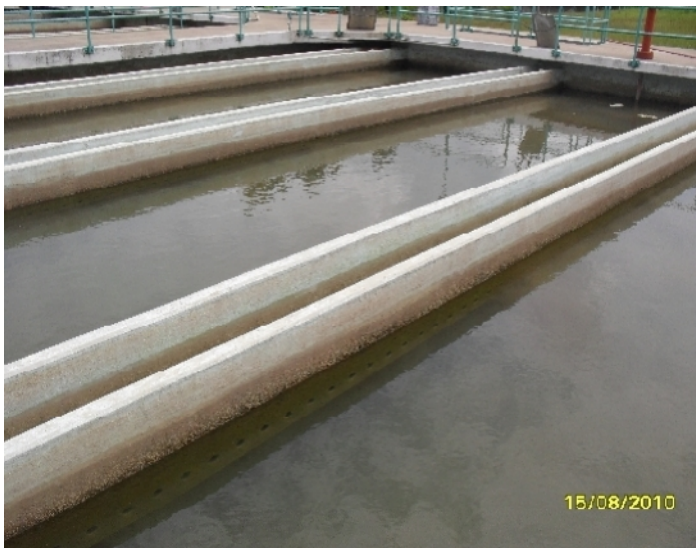
Estancamiento de aguas de la planta de tratamiento Lo de Coy Mixco
