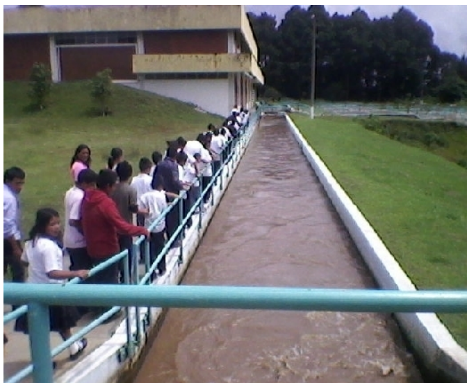
Recorrido por los tanques de aguas de la planta de tratamiento
