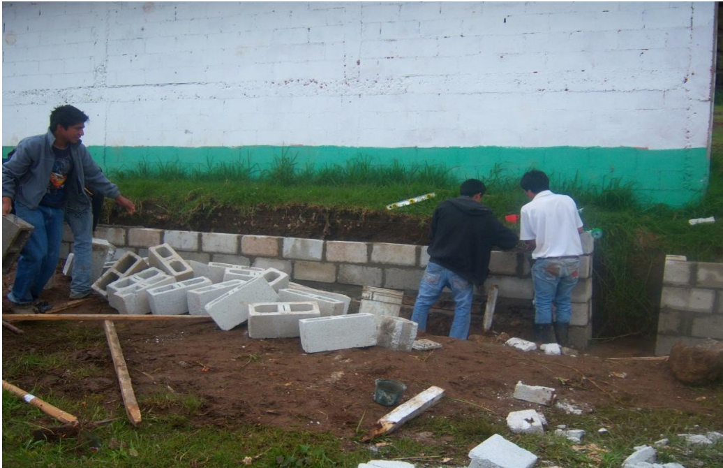
Foto. Se observa la construcción de la jardinera.
