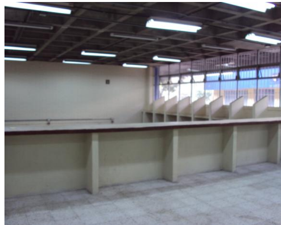
Fotografía 9 Aquí se observa la iluminación escasa y la ventilación
