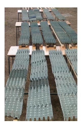
4.- Se lleva a cabo el secado de los cartones. Luego que son sumergidos en el agua de cemento con pintura, ( la pintura que se utilizó al final fue pintura de piso en polvo) se colocan en un lugar apropiado en el que los cartones obtengan aire y sol. Ese secado lleva aproximadamente 20 minutos.
