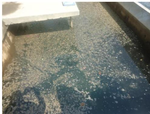
En algunas ocasiones el lodo dentro del canal llega a una altura de un metro debido a la enorme cantidad de partículas que viene entre el agua de los ríos. Esta es la tarea del Sulfato de Aluminio, separar el agua de las partículas para que, conforme va pasando por los filtros se va aclarando.
