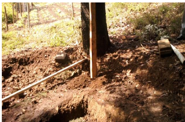
Colocación de poste para techo.
