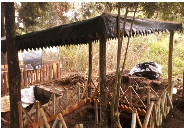
Colocación de nylon para techo.
