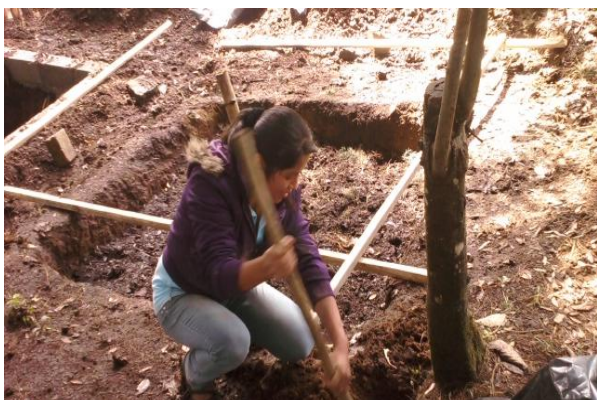
Realización de agujero para poste.
