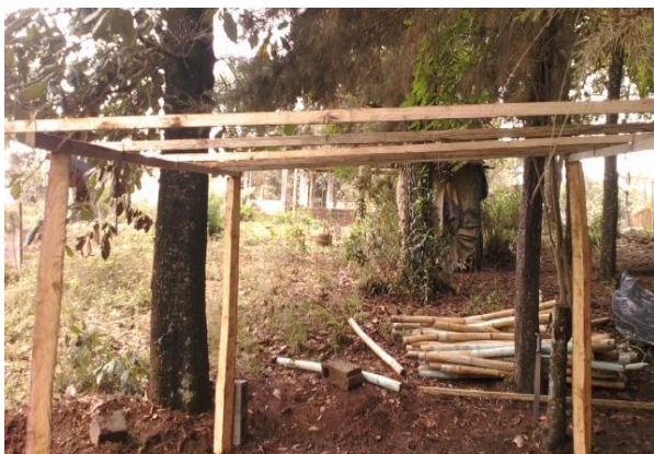
Colocación de madera para techo.
