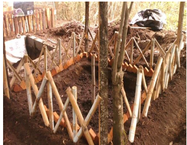
Colocación de bambú para cerco.
