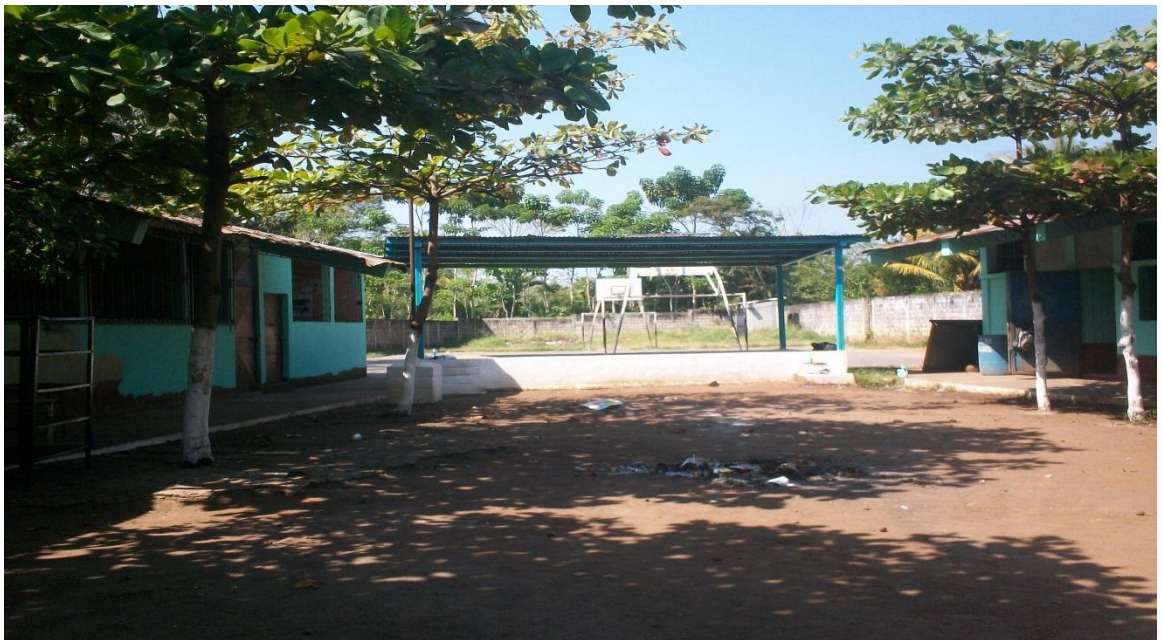
1y 2 infraestructura de la Escuela Oficial Rural Mixta J.M. Sector El Zapote, Aldea San Luis, San Sebastián, Retalhuleu.
