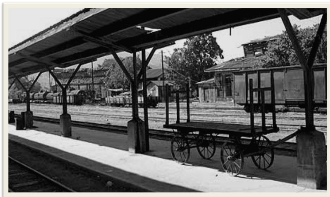
Estación del ferrocarril en Zacapa. Vagones y tanques de combustible (Fondo a la izquierda).
