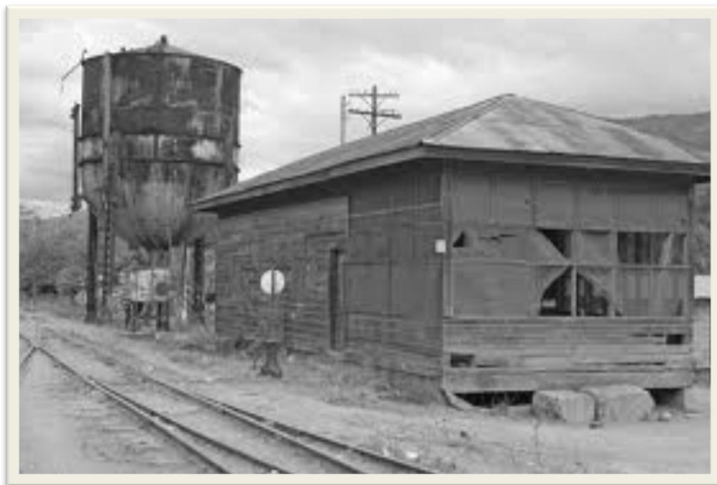
Antigua estación de servicio y abastecimiento de agua para el ferrocarril.
