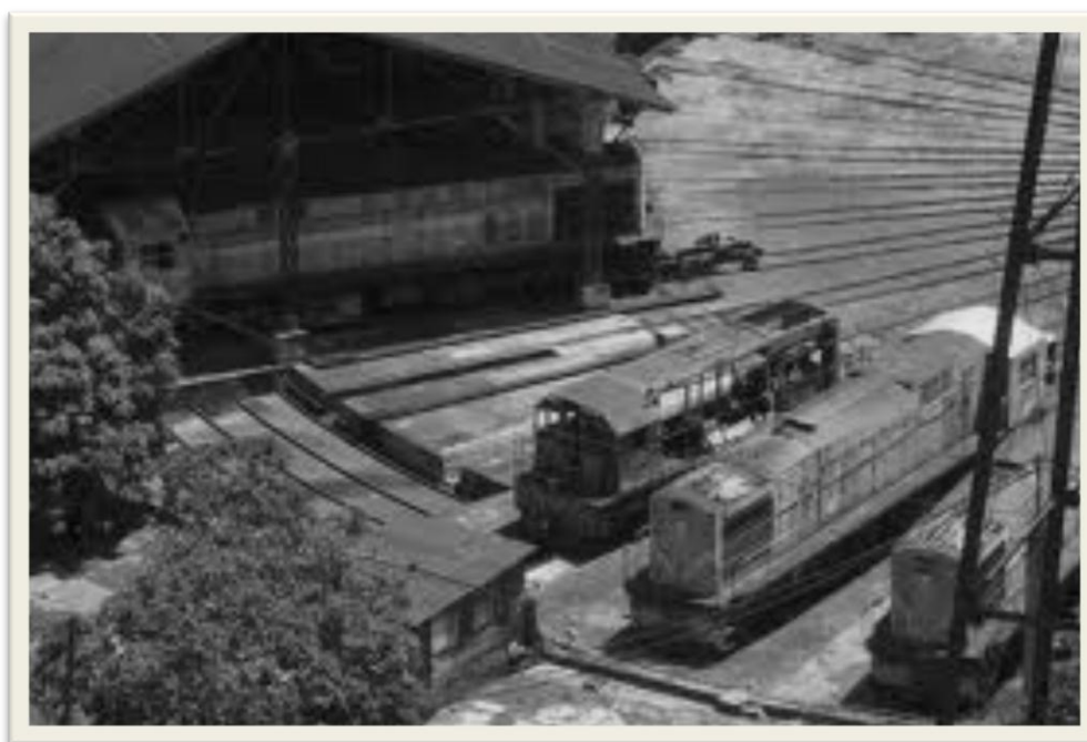
Patio de FEGUA.
