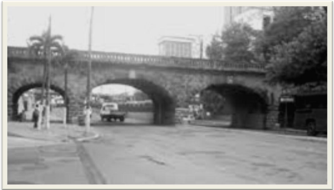
Vista actual del puente del ferrocarril en 7ª avenida zona 1 Centro Cívico, Ciudad Guatemala.
