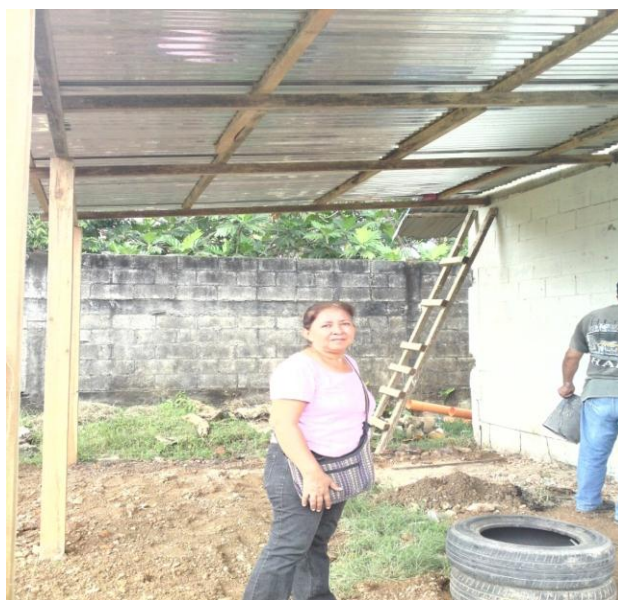
Limpieza del lugar y finalización del techo del área de descanso
