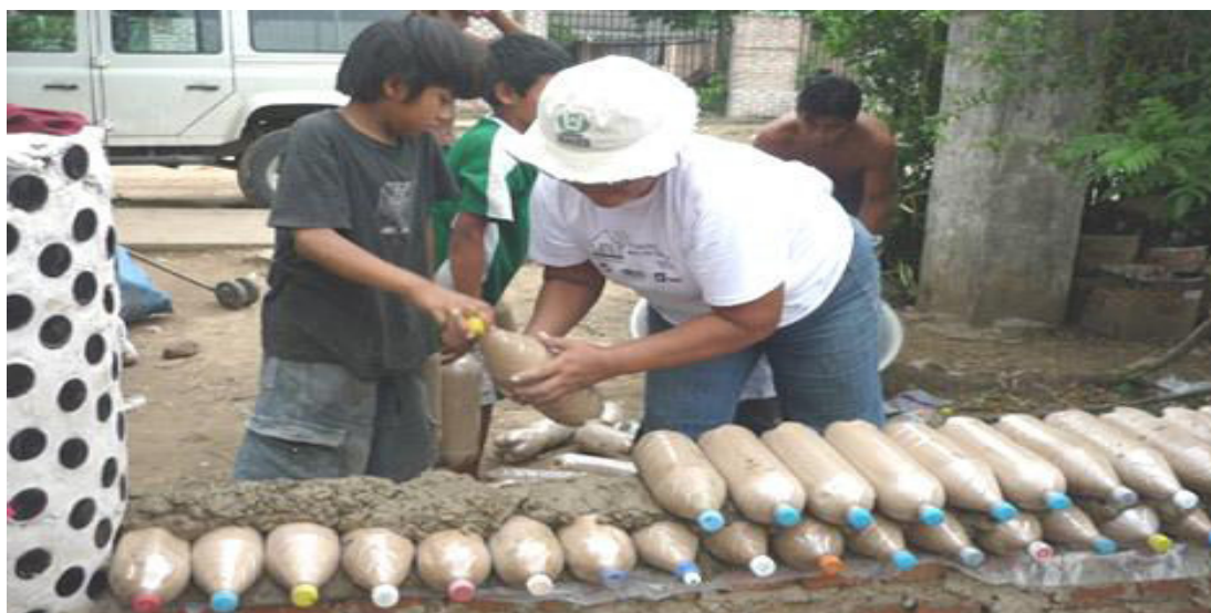
Construcción de muros
