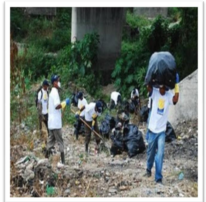
Proceso de limpieza en el área del puente del río Nahualate
