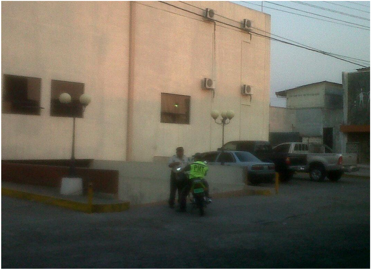
Parqueo de la Municipalidad Costado derecho fotografía tomada por el epesista Kilder Mérida
