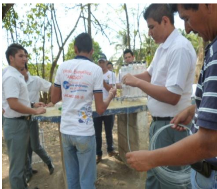
Alumnos cortando alambre de amarre galvanizado, de acuerdo a la medida dada por el epesista y colocando las botellas plásticas en su lugar.
