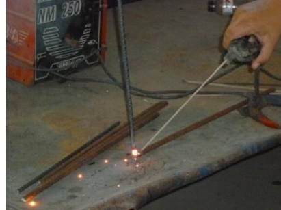
proceso de soldadura de hierro
