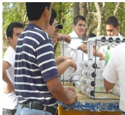
Alumnos cortando alambre de amarre galvanizado, de acuerdo a la medida dada por el epesista y colocando las botellas plásticas en su lugar.
