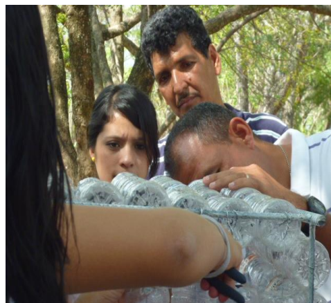
Alumnas cortando alambre y colando las botellas plásticas en su lugar para proceder a amararlas y supervisadas por el catedrático Carlos Franco y Epesista Eduardo Juárez .
