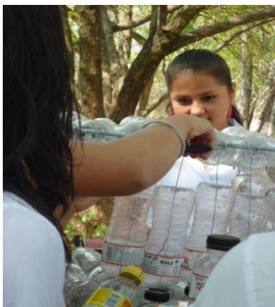
Alumnas cortando alambre y colando las botellas plásticas en su lugar para proceder a amararlas y supervisadas por el catedrático Carlos Franco y Epesista Eduardo Juárez .
