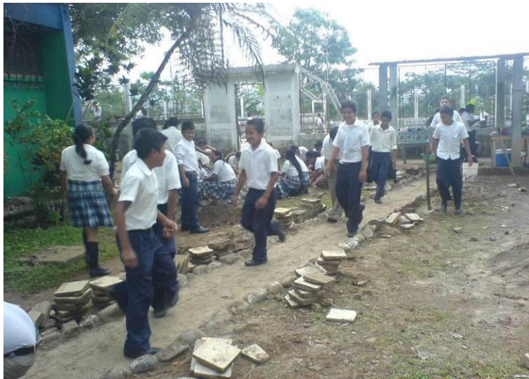
Compactando antes de colocar el material
