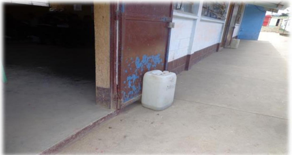
Depósitos de agua que abastece las necesidades (antes de proyecto)
