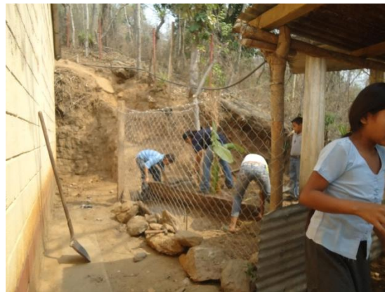
PREPARACION DE ARRIATES
