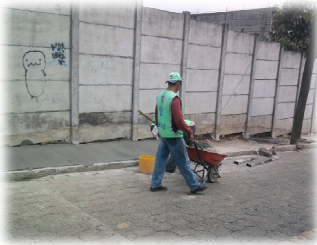
Construcción de la banqueta por trabajadores de la municipalidad.
