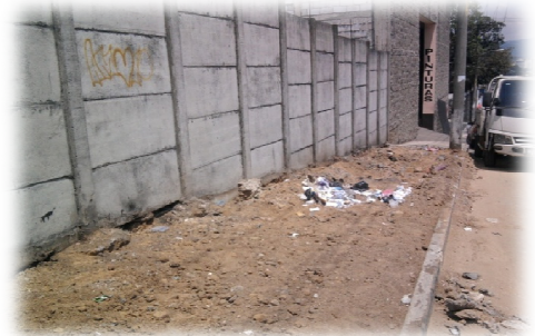
Preparación del área para construir la banqueta
