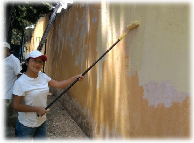
Aplicación de pintura en paredes con rodillo
