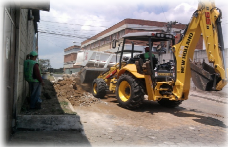
Levantamiento de tierra con maquinaria de la municipalidad.
