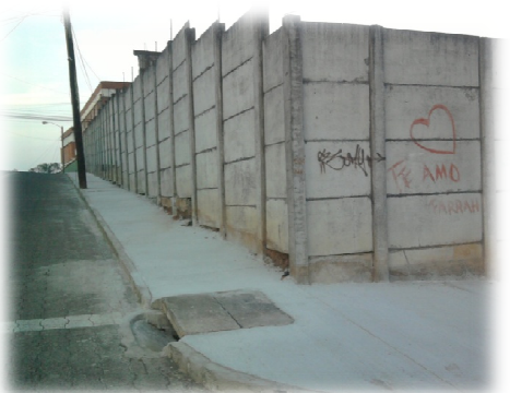
Banqueta terminada y eliminación total del basurero clandestino.
