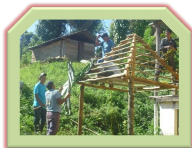
Fuente: fotografía tomada por Epesista María del Carmen CucPaau Formando el techo del rancho ecológico en la Escuela Oficial Rural Mixta "comunidad Chajmacan"
