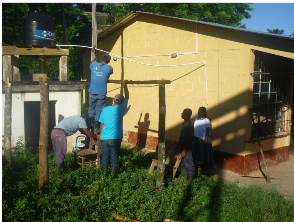
Fotografía No. 10 la colocación de las bases para la construcción de ranchos ecológicos.
