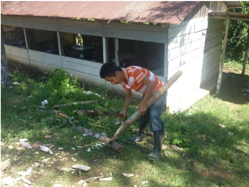
Fotografía No. 16. Alumnos trabajando en la colocación de sillas
