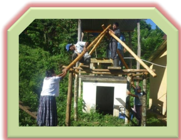
Fuente: fotografía tomada por Epesista María del Carmen CucPaau Colocando el techo del rancho ecológico en el corredor del establecimiento educativo
