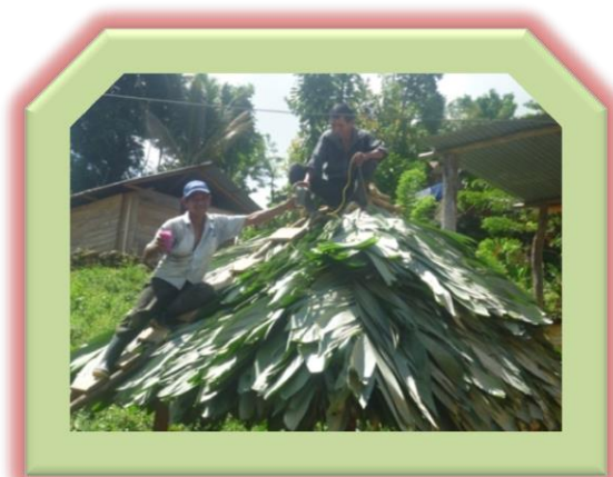
Fuente: fotografía tomada por Epesista María del Carmen CucPaau Formando el techo del rancho ecológico
