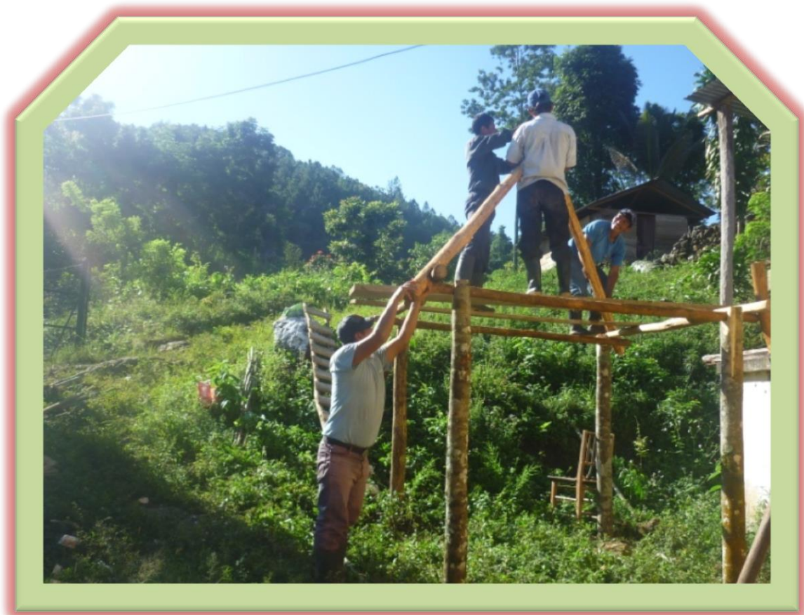
Fuente: fotografía tomada por Epesista María del Carmen CucPaau Los capacitados colocando la ensambladura respectiva
