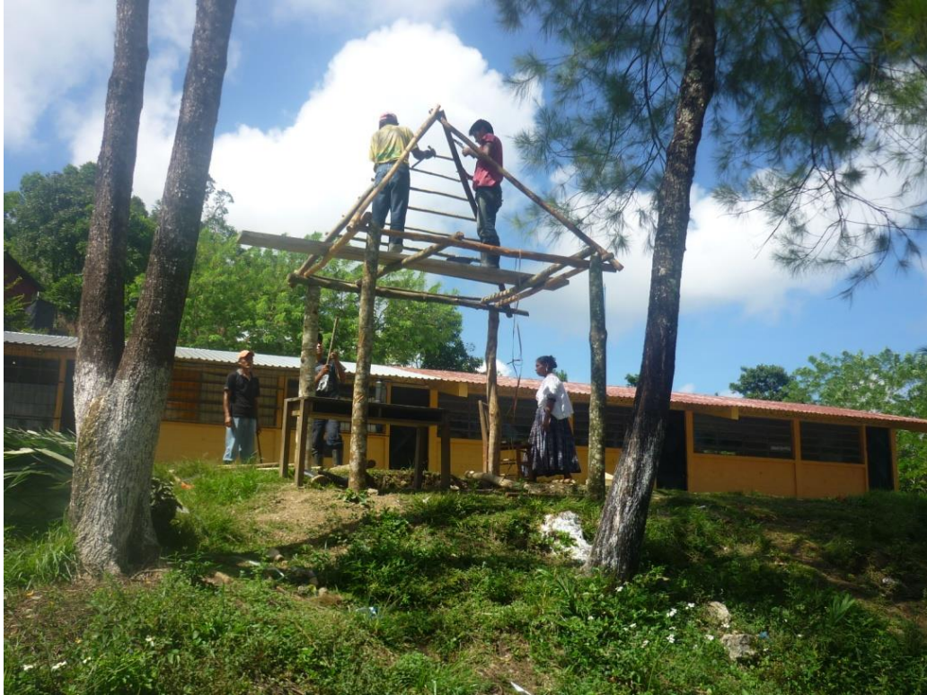
Fotografía No. 11 la colocación de las bases para el techo.
