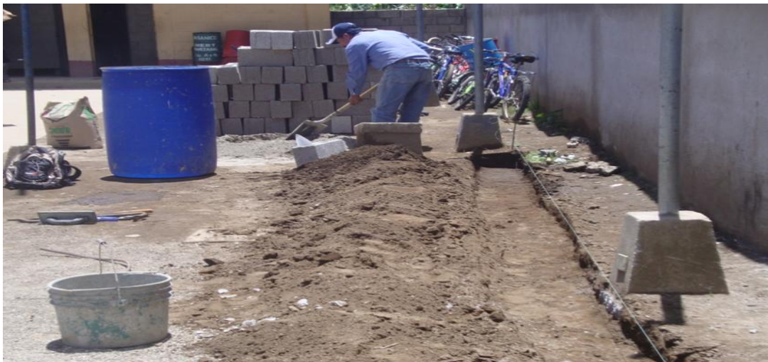
Albañil realizando la zanja para iniciar el proyecto
