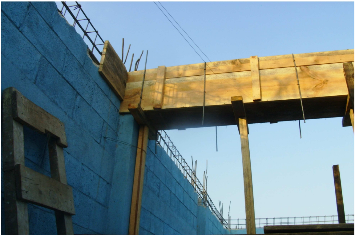
Elaboración de columnas para reforzar paredes.
