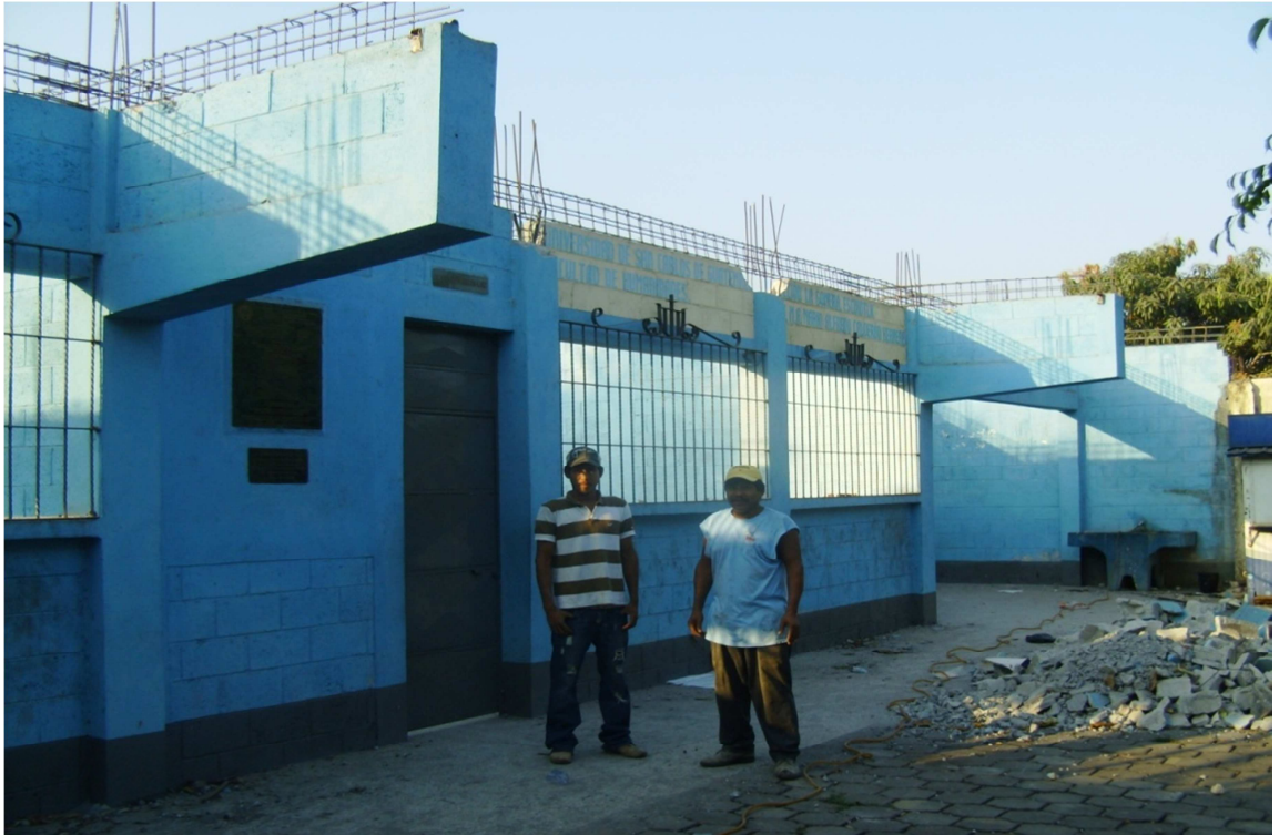
Reforzamiento de paredes
