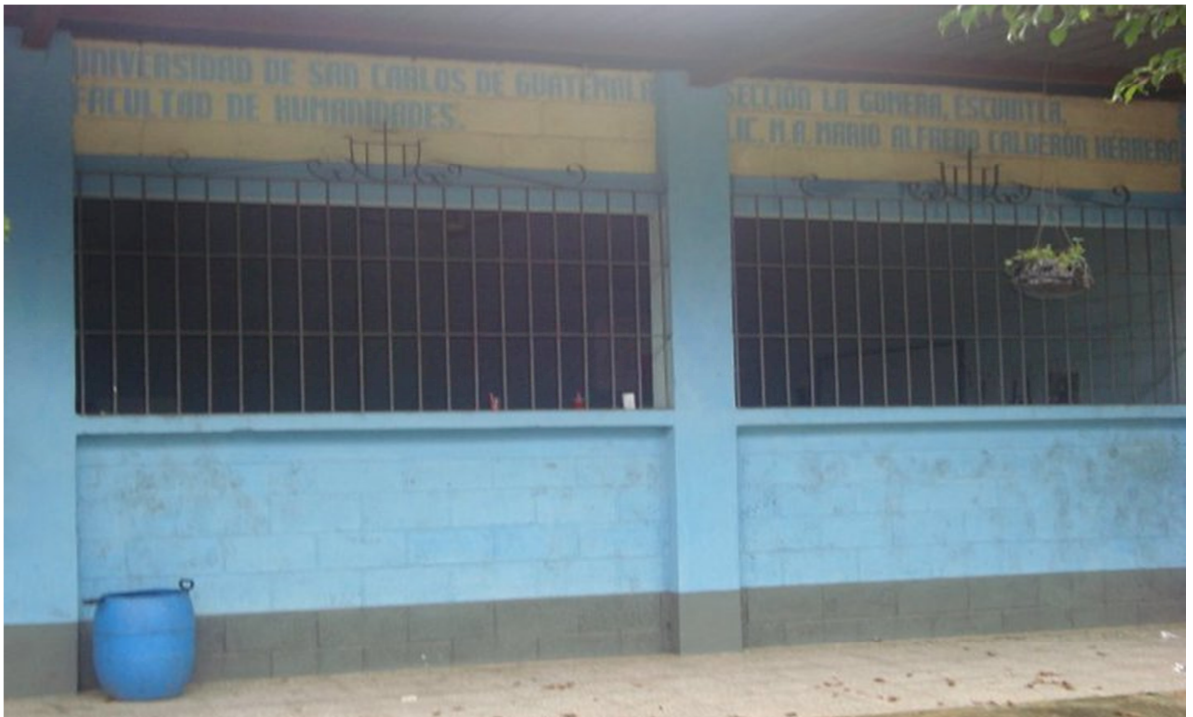
Aulas con poca ventilacion
