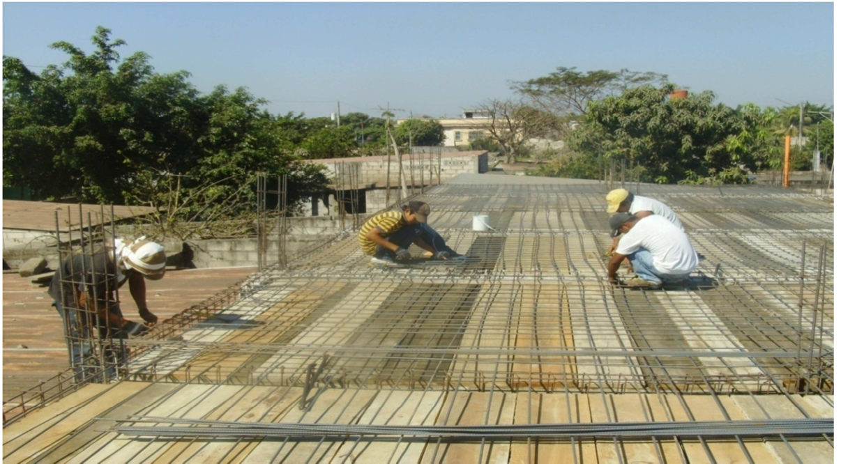
Elaboración de formaleta para construcción de terraza
