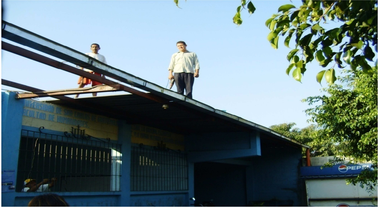
Universidad de San Carlos desmantelacion de techo de la mina
