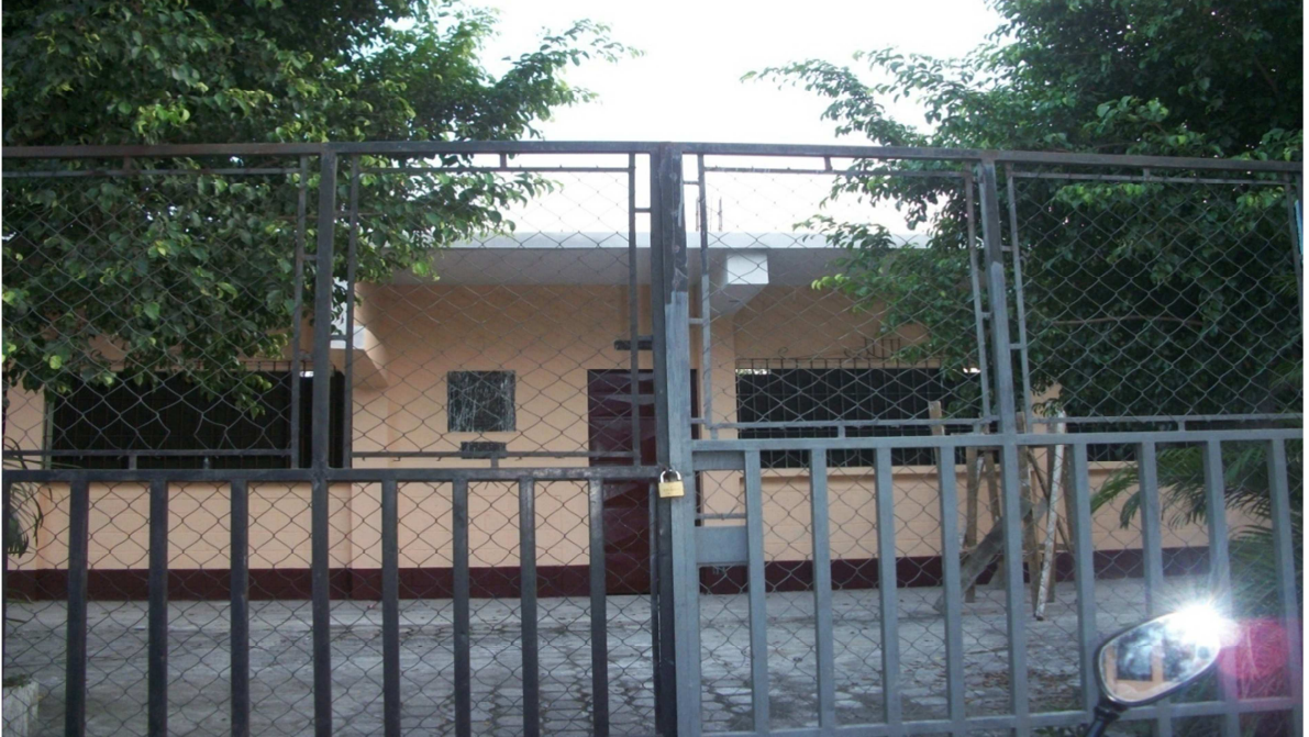
Universidad de San Carlos con terraza construida
