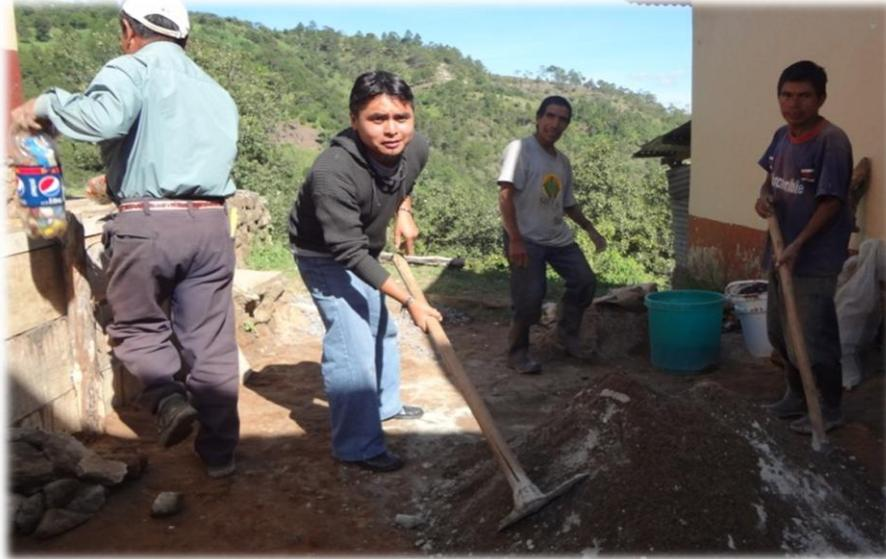
Preparación de mezcla de concreto utilizada en el proyecto.
