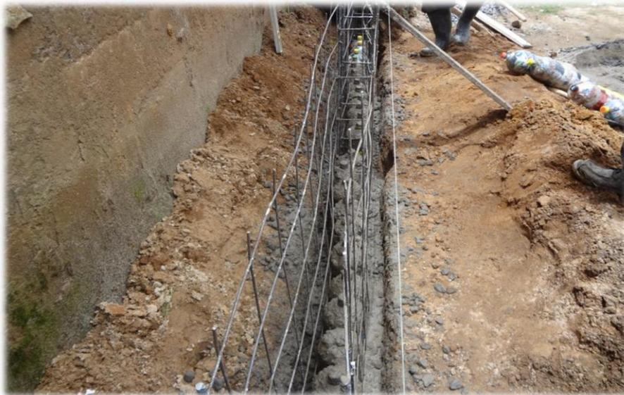
Construcción de muro de Contención a base de Material Pet.
