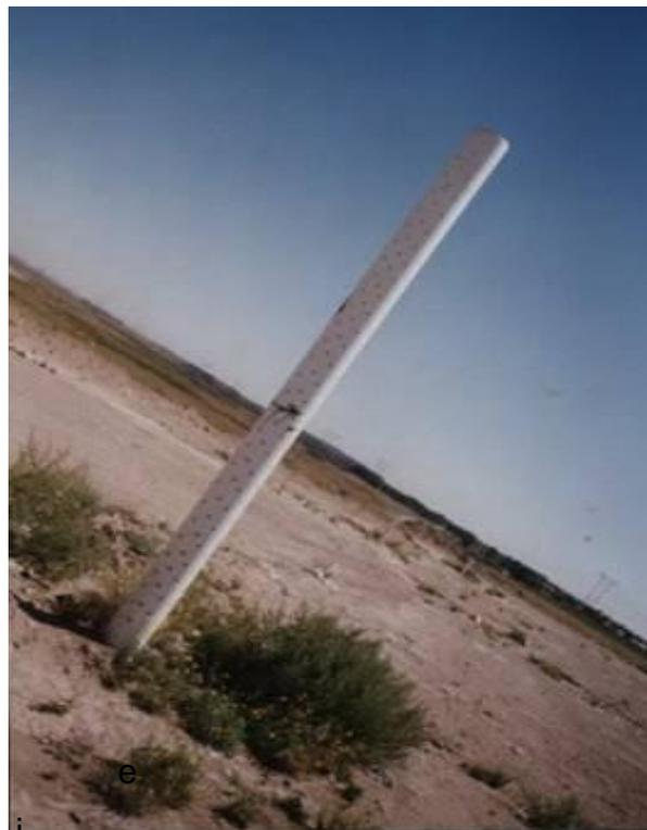
Ejemplo de una chimenea de evacuación, de gases. Fuente: <http://images.google.com.gt/imgres?im>
