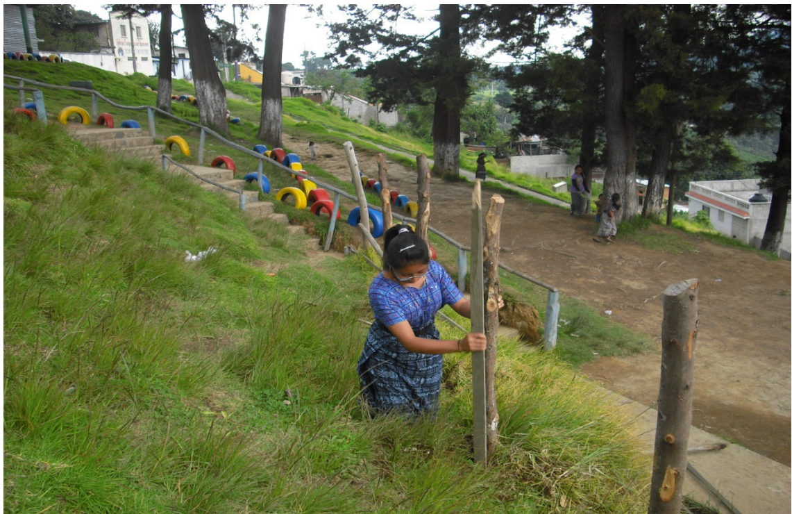
Construcción de cerco por epesista.
