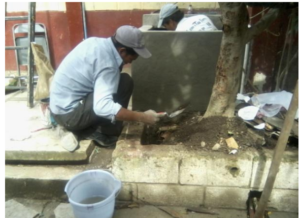
Fontanero y su ayudante finalizando la pileta
