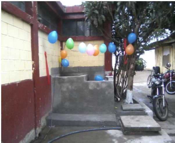
Vista cómo quedó la nueva pileta
