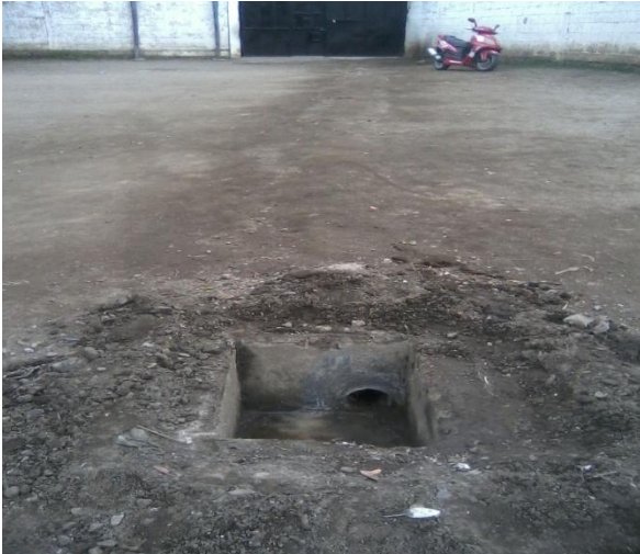
Vista de instalación de drenaje y reposadera
