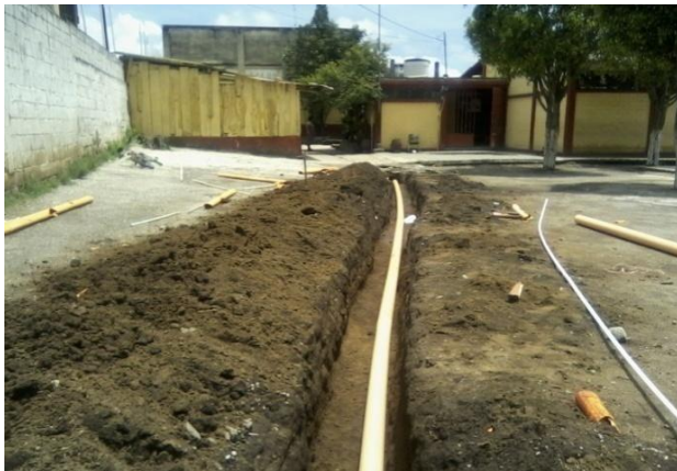
Instalación de la tubería para el drenaje
