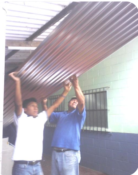
Alumnos colaborando en la colocación de láminas.
