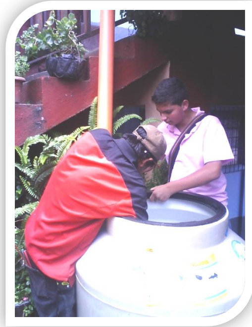
Pegando tubo en el tinaco.
