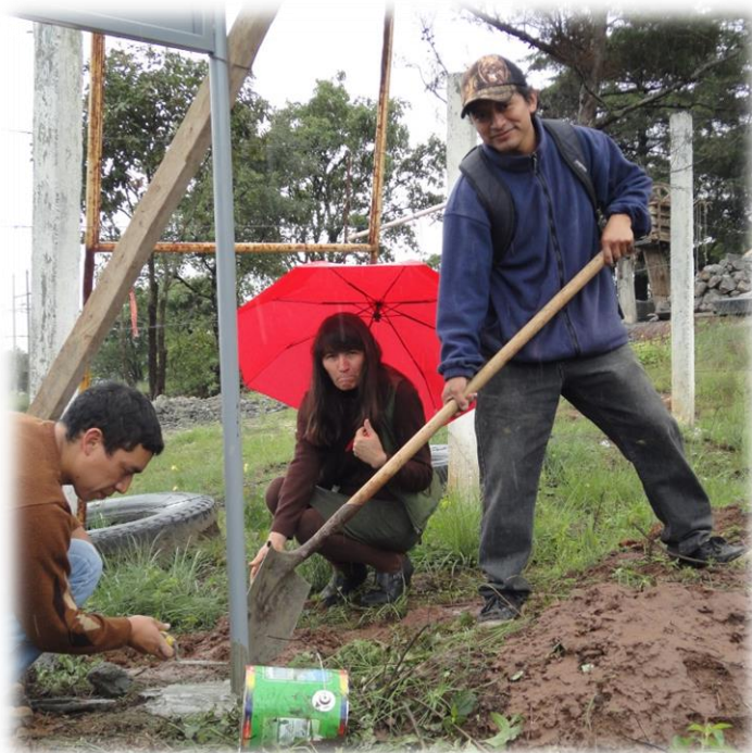
Figura No. 13 Colocación de la valla publicitaria. Epesista colaborando en la colocación de la valla publicitaria
