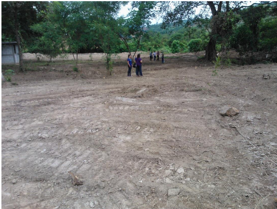
Área después de arreglarla
