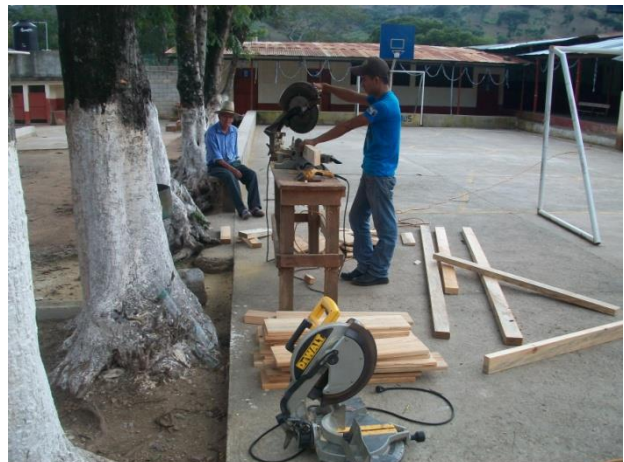
foto en el proceso de instalación de la madera en el proyecto. Septiembre 2013
