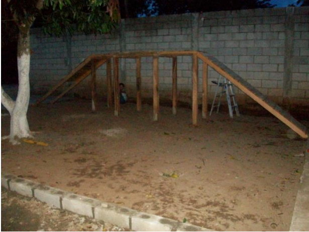
foto tomada en la primera fase del proyecto Septiembre 2013
