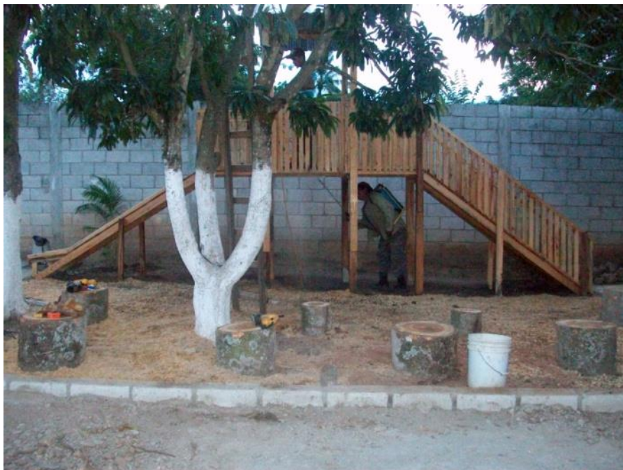
Foto tomada con el parque infantil terminado, septiembre 2013
