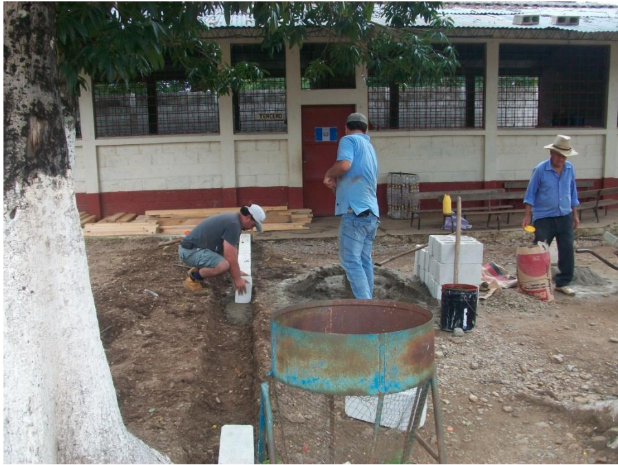
Foto tomada en el lugar de la elaboración del parque infantil, Escuela Oficial Rural Mixta de El Porvenir, San Diego, Zacapa.
