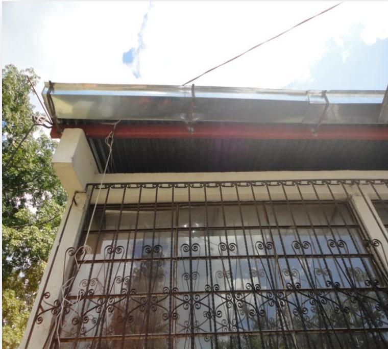
(Foto tomada por la Epesista, en una perspectiva para que vean el tipo de canal colocado en el aula destinada para la captación de agua de lluvia)
