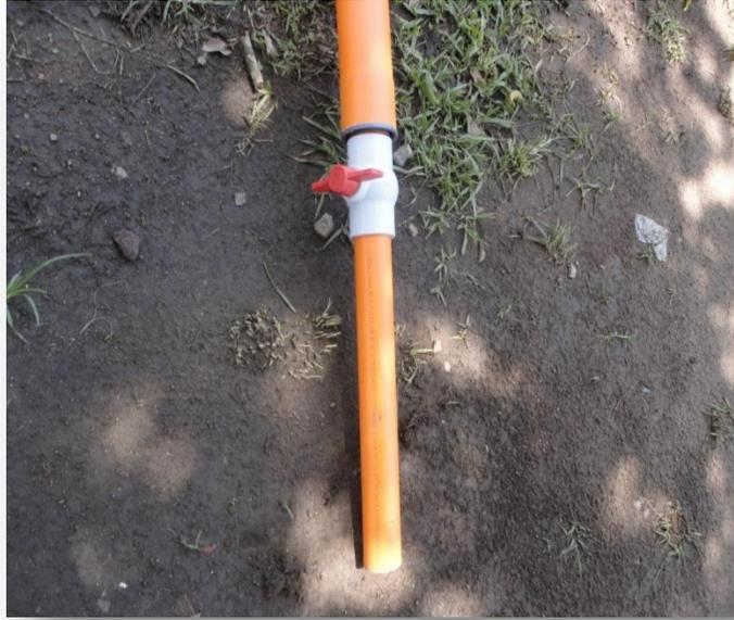
(Imagen tomada por la Epesista, esta imagen muestra como queda la llave, después de pegar el tubo, la llave, y colocar la pelota dentro de la tubería, para evitar que se ensucie el agua, teniendo así una mejor limpieza en la conducción del líquido hacia el tinaco)
