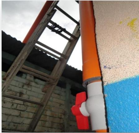
(Imagen tomada por la Epesista, dando a conocer el decantador, que servirá para que no pase agua sucia, como basuras, desechos que en los techos siempre hay, todo esto con el fin de que el agua que caiga en el aljibe sea de mejor calidad y esto no impida que la tubería se tape)
