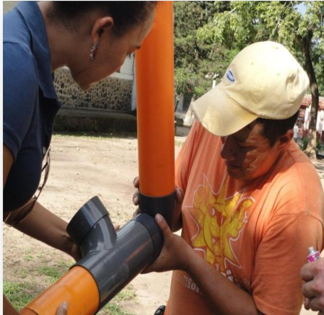
(Imagen tomada por la Epesista, momento en el que se están pegando los tubos para instalarlo y que quede en buenas condiciones para la captación de agua de lluvia)
