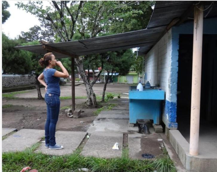
Foto tomada por la Epesista Carmen Graciela García, aquí estaba observando el lugar de la caída del tubo que es recibido del tejado de atrás de los sanitarios. Tomando las alternativas, para la ubicación del tubo que caerá hacia el tinaco. Este queda muy bien a un lado del lavadero, enfrente de los sanitarios.
