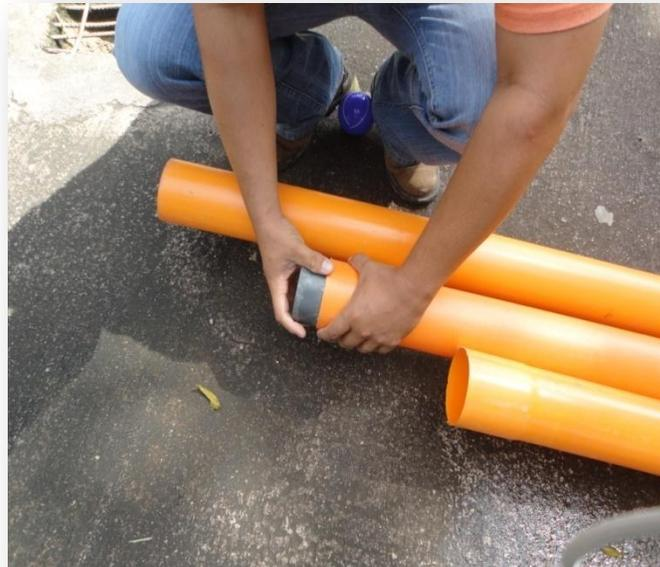
(Foto tomada por la Epesista, dando a conocer la forma en que se coloca el reducidor de diámetro de tubería en el tubo, para luego colocar la pelota adentro y pegar los tubos, quedando así listo para dejar el decantador a su uso, para limpieza del agua en invierno).
