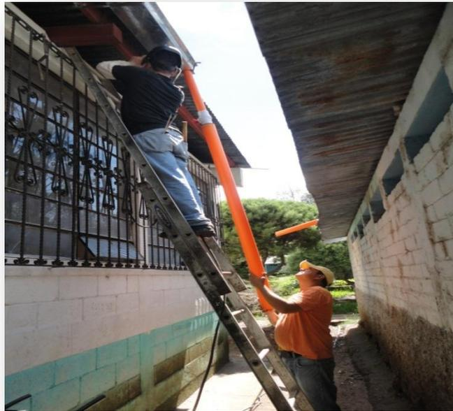
(Imagen tomada por la Epesista, en donde se esta colocando el canal y reforzándolo a manera que quede bien instalado)
