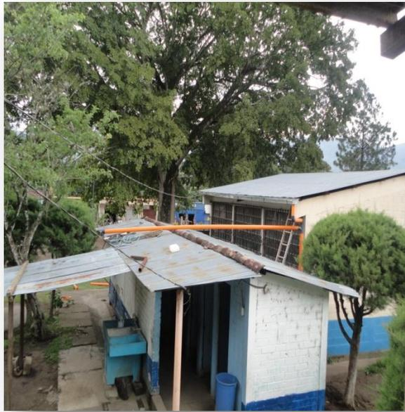
(Imagen tomada por la Epesista, aquí se muestra en la imagen que la captación de agua de lluvia esta tomada estratégicamente de un aula y lo conducirá por medio del canal a la tubería, éste colocándose en declive para que el agua no se empoce, sino que, se conduzca a su destino)
