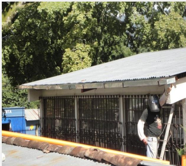
(Imagen tomada por la Epesista, terminando de colocar el canal, para luego colocar la tubería)
