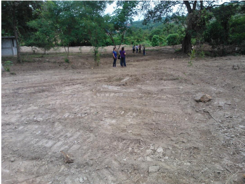
Área después de arreglarla
