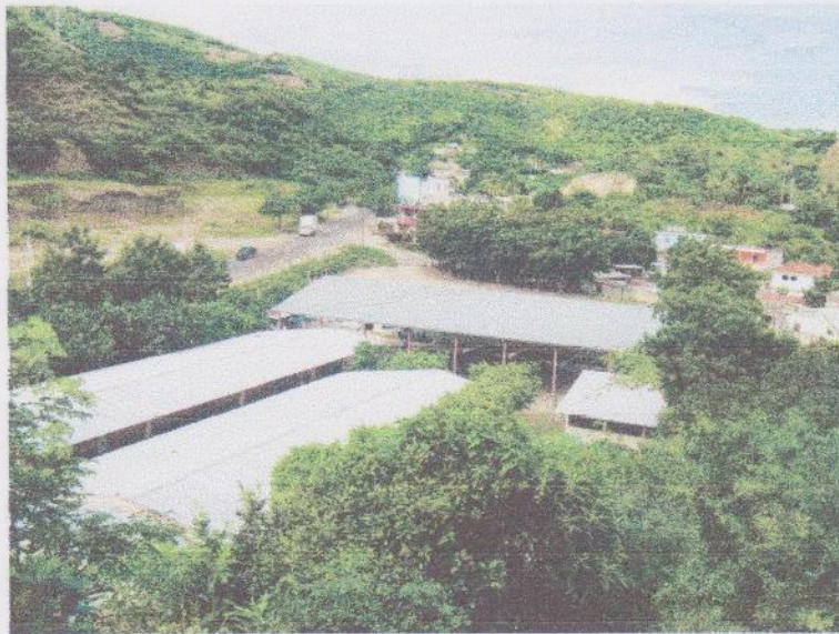
Fotografía de Escuela de Casas Viejas, Guastatoya
