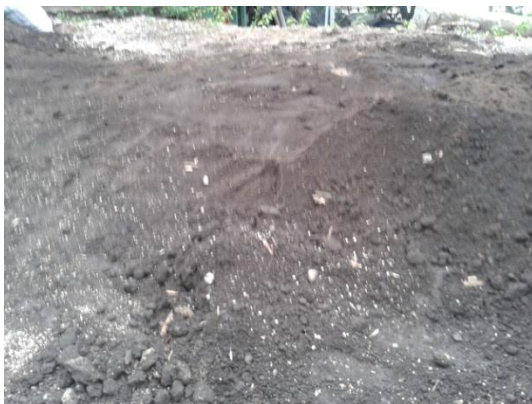
Preparando el terreno
