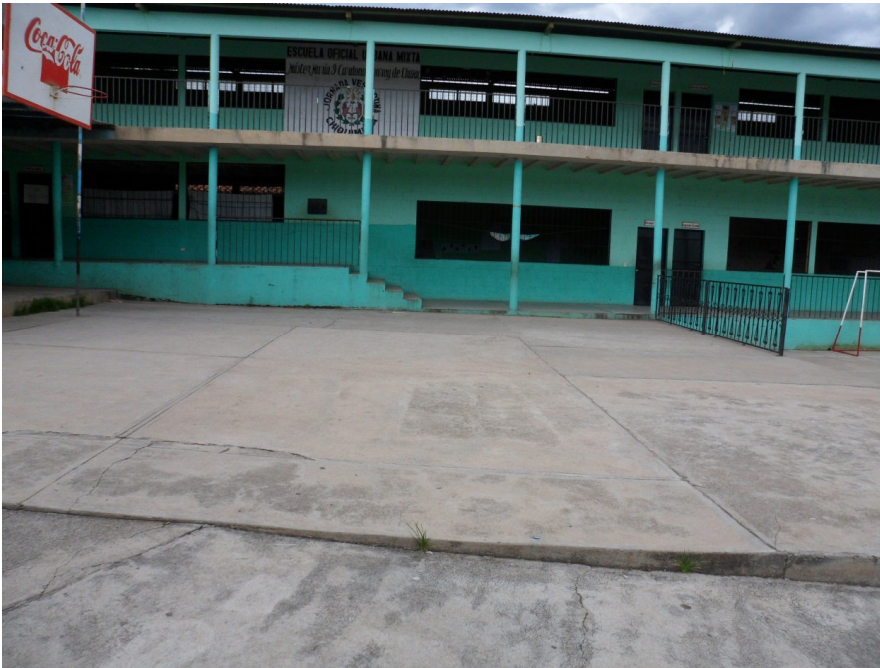
Vista interna del edificio de la EOUM JV Máster María I. Cardona Monroy de Chavac.
