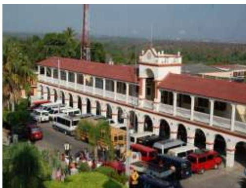
EDIFICIO MUNICIPAL DE ZACAPA
