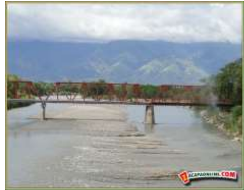
* Puente negro , que daba acceso a la ciudad de Zacapa por la Vía Férrea. (Se construyó nuevamente debido a desastres naturales "Tormenta Mitch", actualmente pintado de color rojo.
