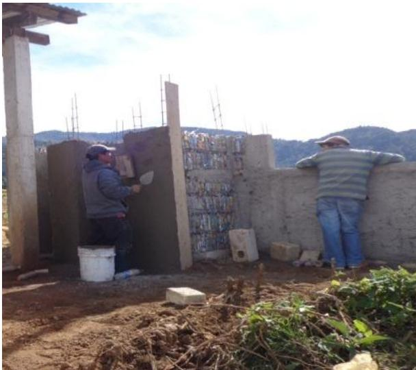
✓ **Elementos Verticales:** pueden ser de diversos tipos de madera o hierro para elaborar las columnas y soleras, asegurando que el ancho de las piezas sea el mismo que el del Eco-ladrillo que se va usar. Se permite una distancia máxima de 1.50 metros entre estos elementos.
