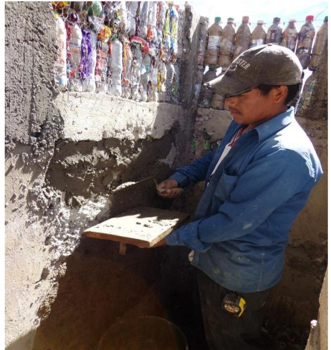
**ACABADO FINAL:** mezcla entre cal y arena en proporción 1:5. Para obtener un mejor acabado y ahorrarse el costo de pintura es posible utilizar; cal torón, Horcalsa y arena blanca o continuar con el cemento.
