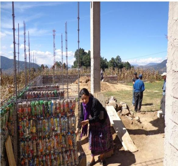
Al terminar de colocar las botellas va teniendo forma y queda como la foto que aquí se muestra.
