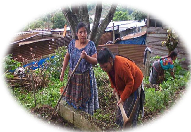
Limpieza y descombre del terreno a utilizar. Foto tomada por epesista
