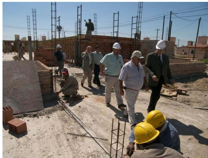
Imagen descargada de www.imagenes.ciudadderiogrande.com Construcción
