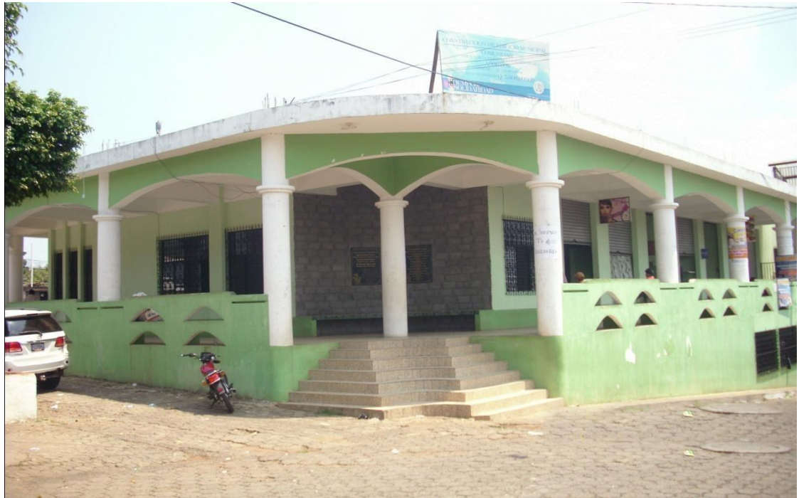
Instalaciones del edificio Municipal de Flores Costa Cuca, Quetzaltenango, Institución Patrocinadora del Proyecto.
