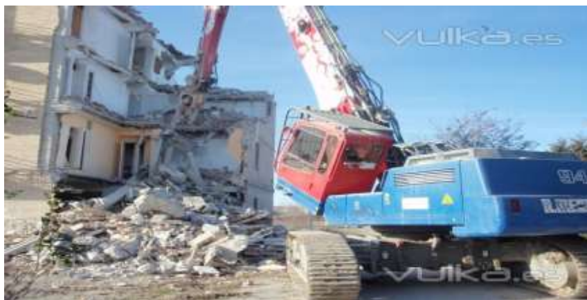
Fuente: https://www.resurgrana.es Camión cargando residuos sólidos de demolición
