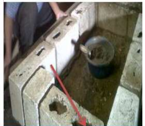
Inicio de la construcción de la base
