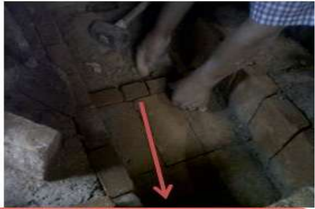
Fotografía de construcción de la cámara de fuego.
