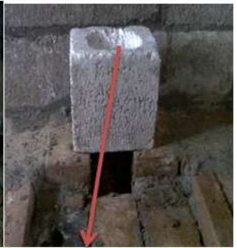
Base para asentar los tubos
