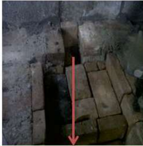
Base de la Chimenea
