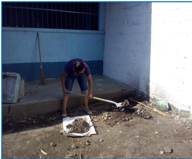
Se terminó de limpiar el área.
