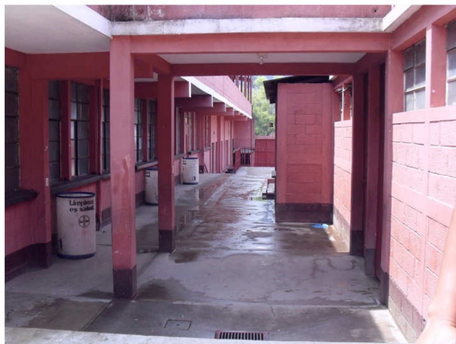
Pasillo primer nivel
