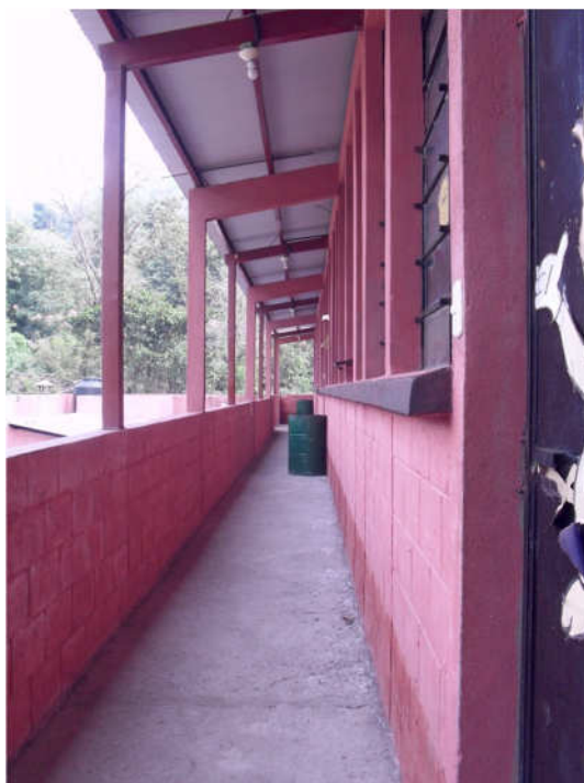
Pasillo segundo nivel
