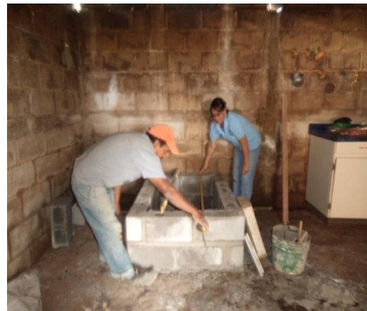
Epesista y albañil, construyendo una Estufa mejorada
