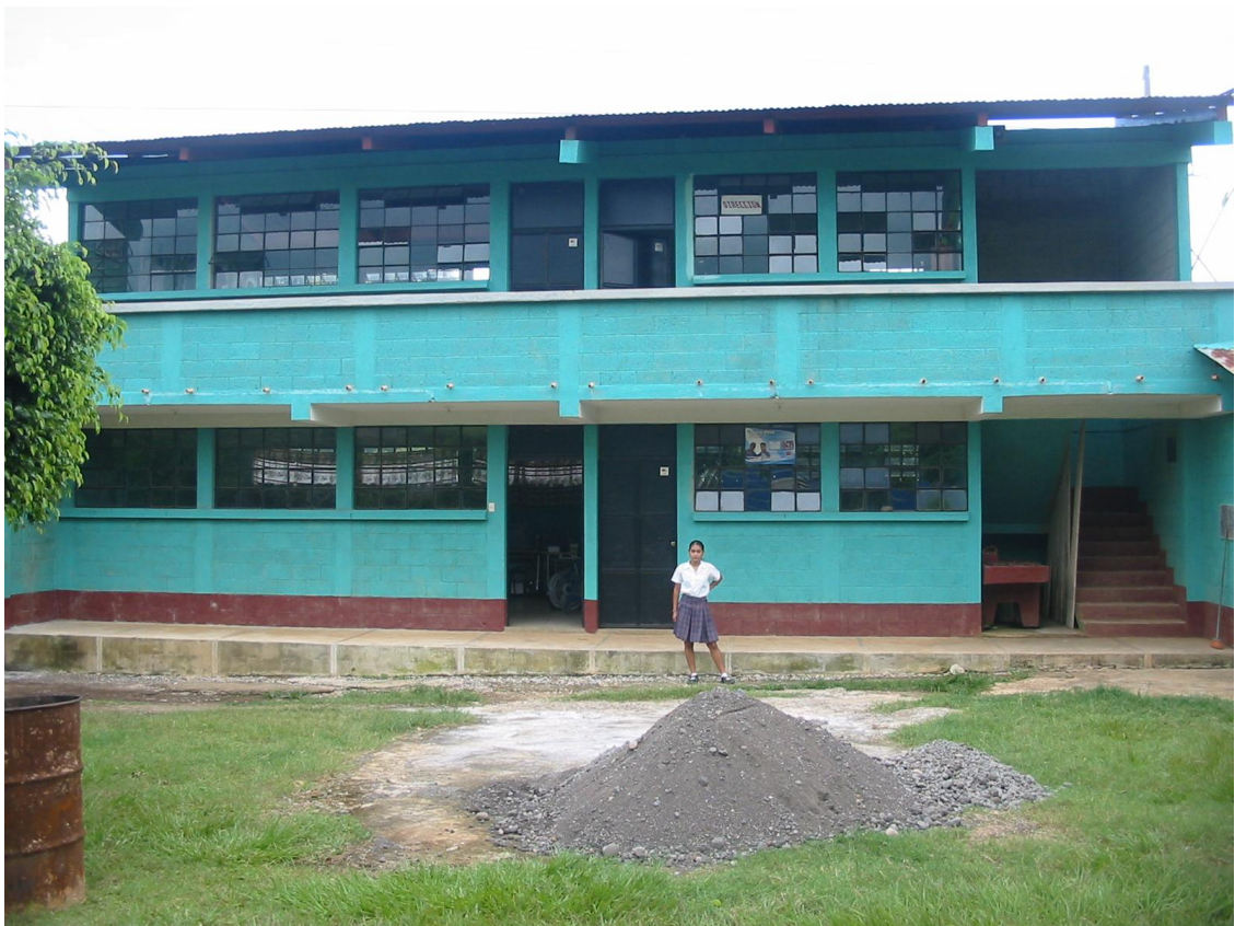
Edificio del establecimiento donde se realizó la socialización
