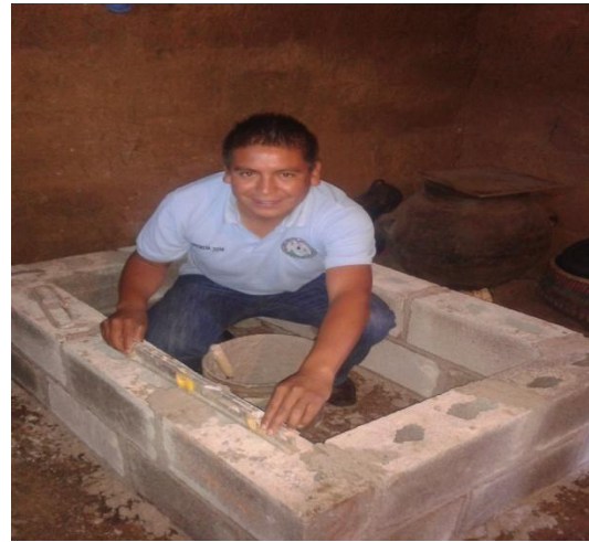
Epesista nivelando el block del cajón
